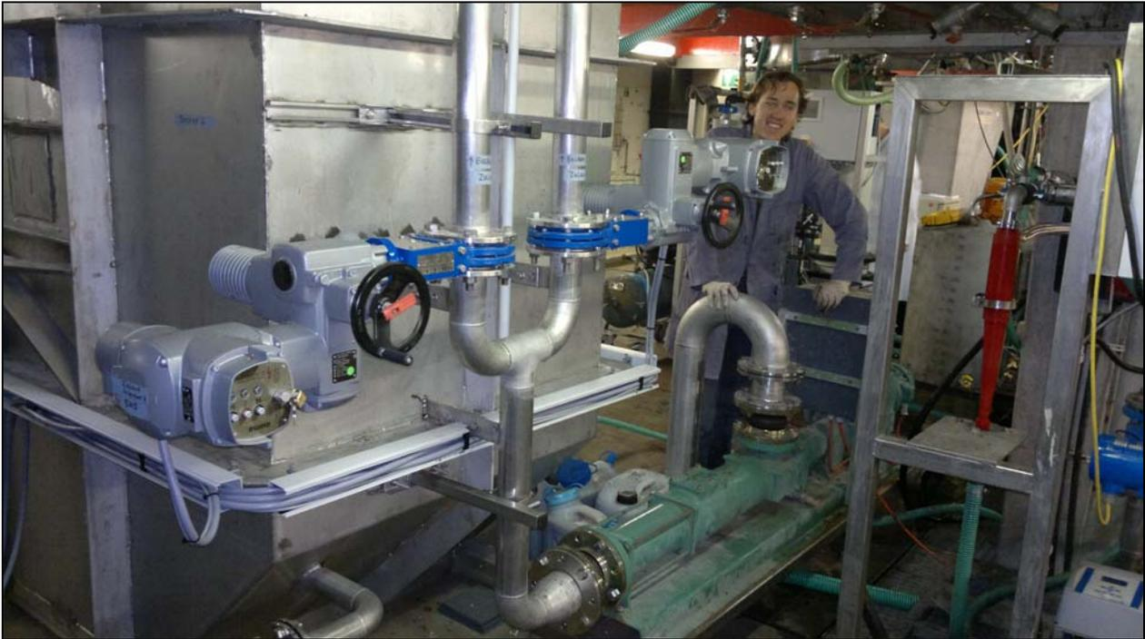
**Abbildung 12:** Technikumsanlage zur Elimination schwerabbaubarer Organik aus Abwasser. Vorderansicht mit zwei Elektroschiebern zur Steuerung der Befüllung mittels Mohno-Pumpe.
